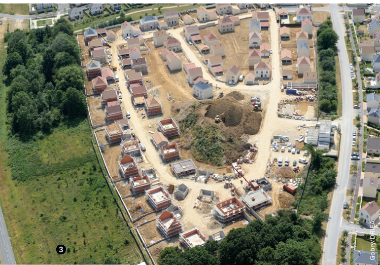
3. Vue aérienne vers Magny-le-Hongre, lotissement pavillonnaire.
