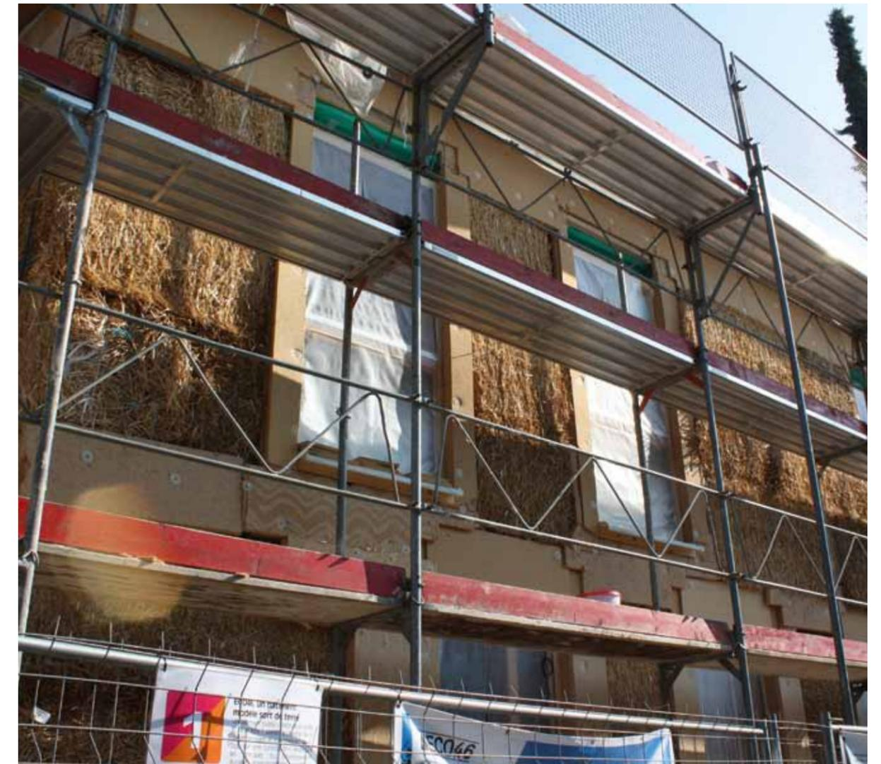
La paille compressée est un matériau de construction et un isolant bio-sourcé efficace et éprouvé. © M. Barra
