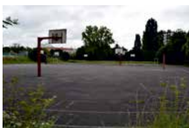
Sportspladser af beton
