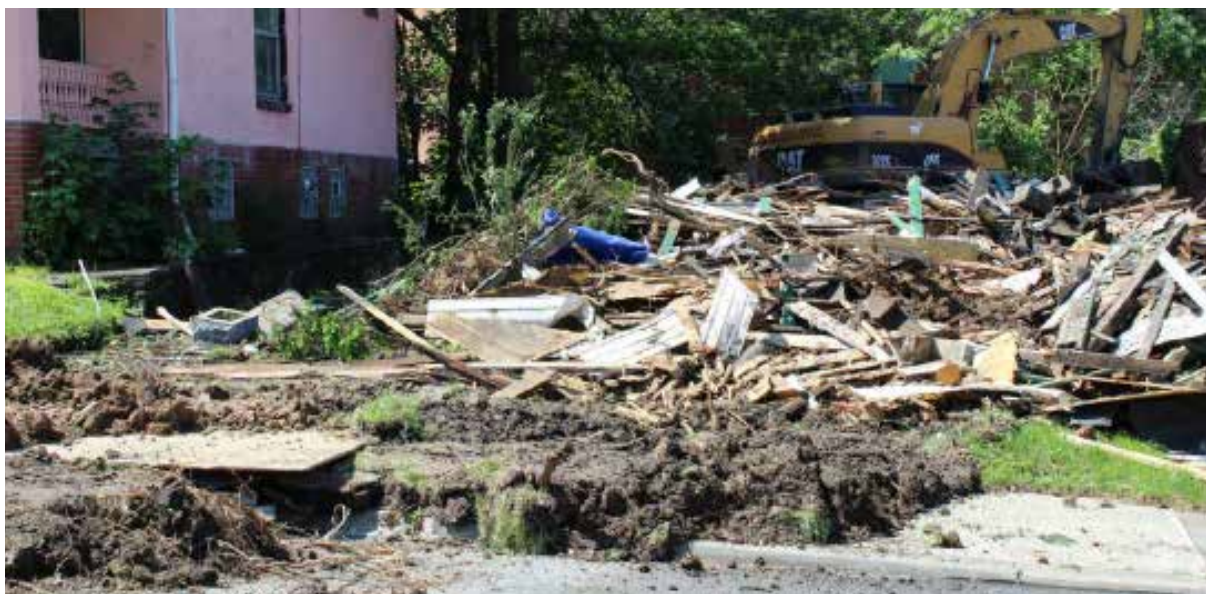
Nedrivning i Cleveland ©Turo og Gardiner, 2020 [23].
